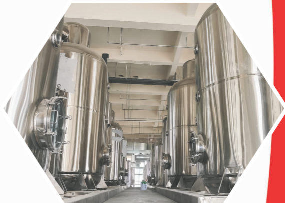
彩虹产业园区设备安装调试。
