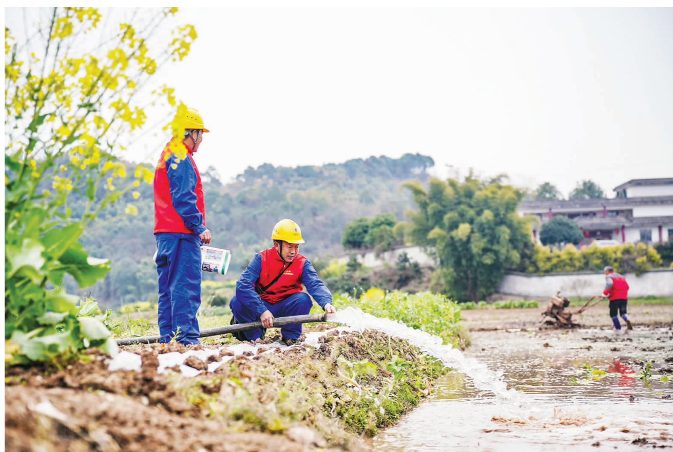
在谢家街道悦园村,电网工人进行抽水电机安全用电检查。
