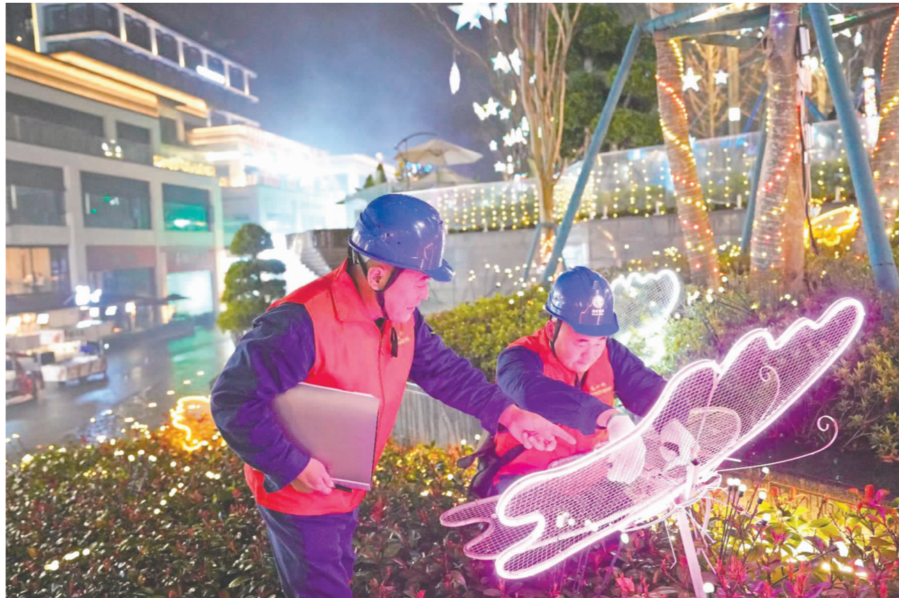
对用电设备进行红外测温。
