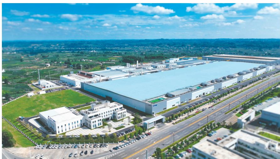
航拍眉山晟升光伏科技有限公司。 罗俊涵 摄
