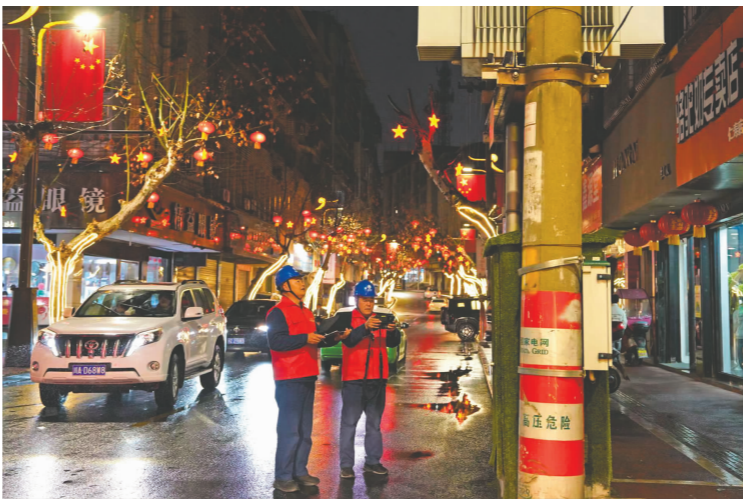
检查商业街区用电设施。
