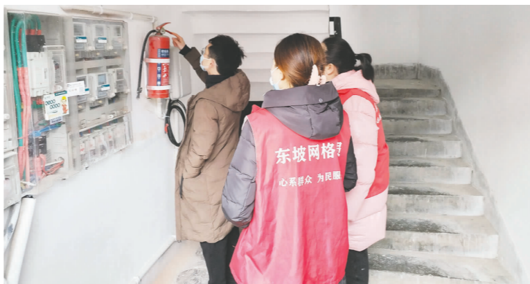
检查消防器材。
