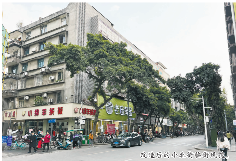
修缮完成的太和老镇房屋。
