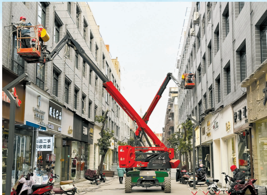
商业东街正在加装雨棚。
