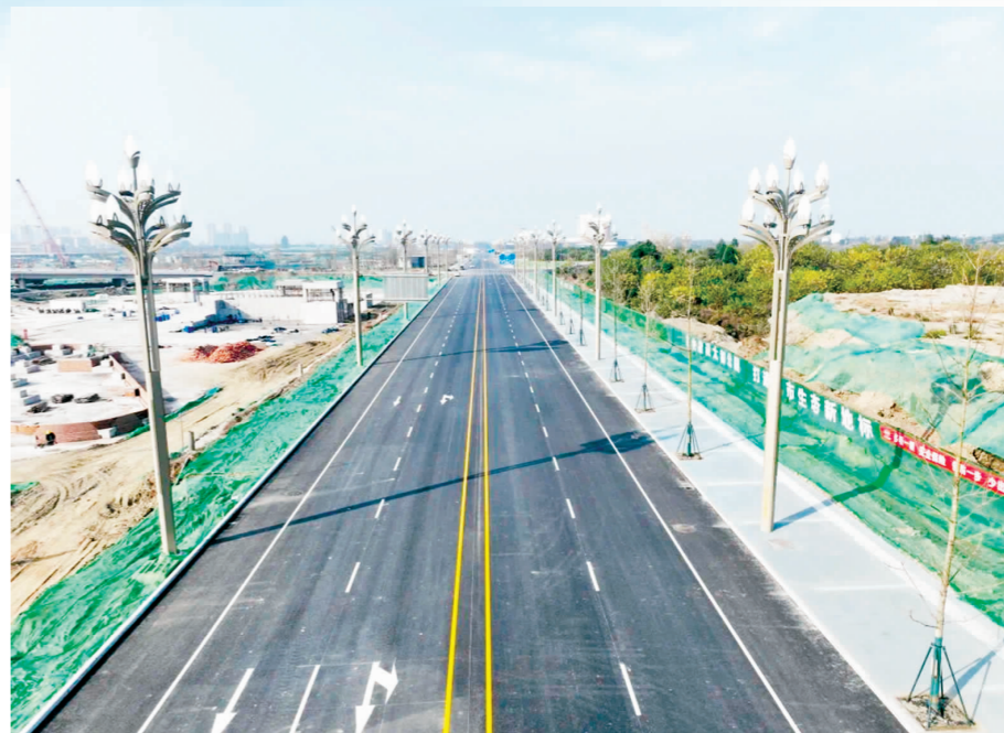
市政道路建设加速推进。眉山日报全媒体记者 陈博 摄
