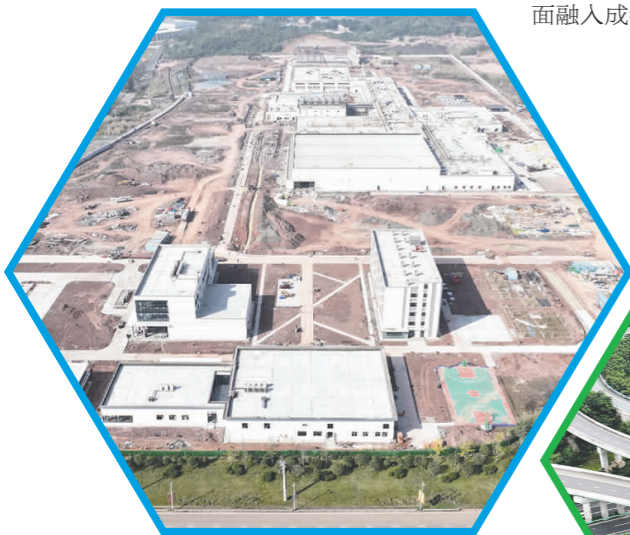
德康(眉山)高端肉制品屠宰加工项目(一期)建设现场。
