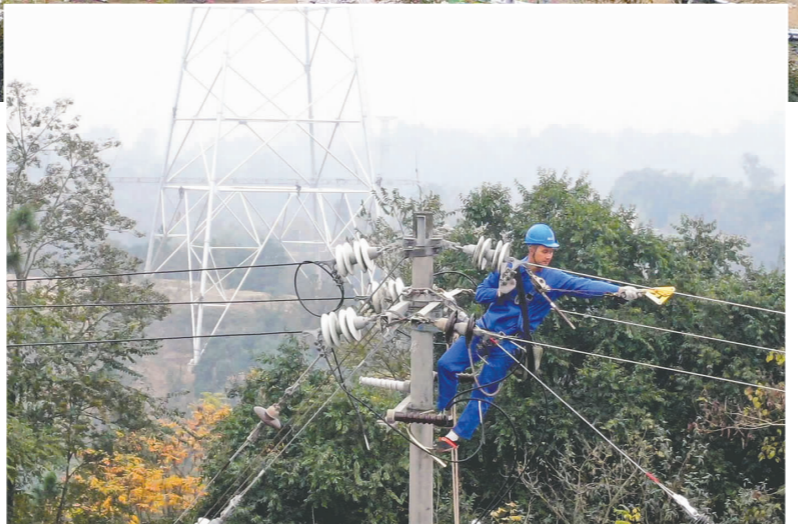
▲特高压施工现场。 ▶电力工人在拆除电线。
