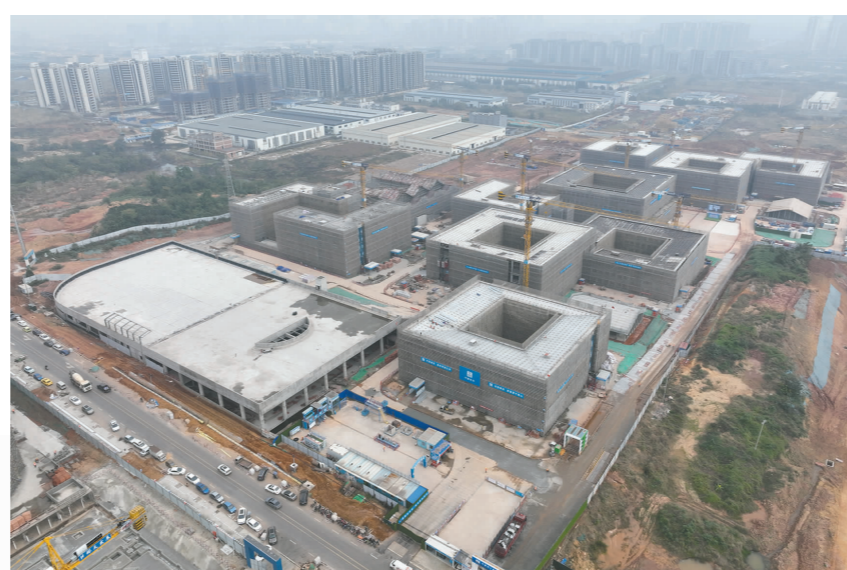
眉山天府学校中学部项目施工现场。
