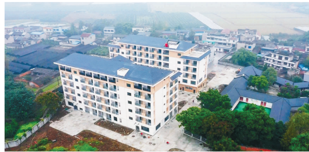
航拍彭山区产业新城养老中心项目。
