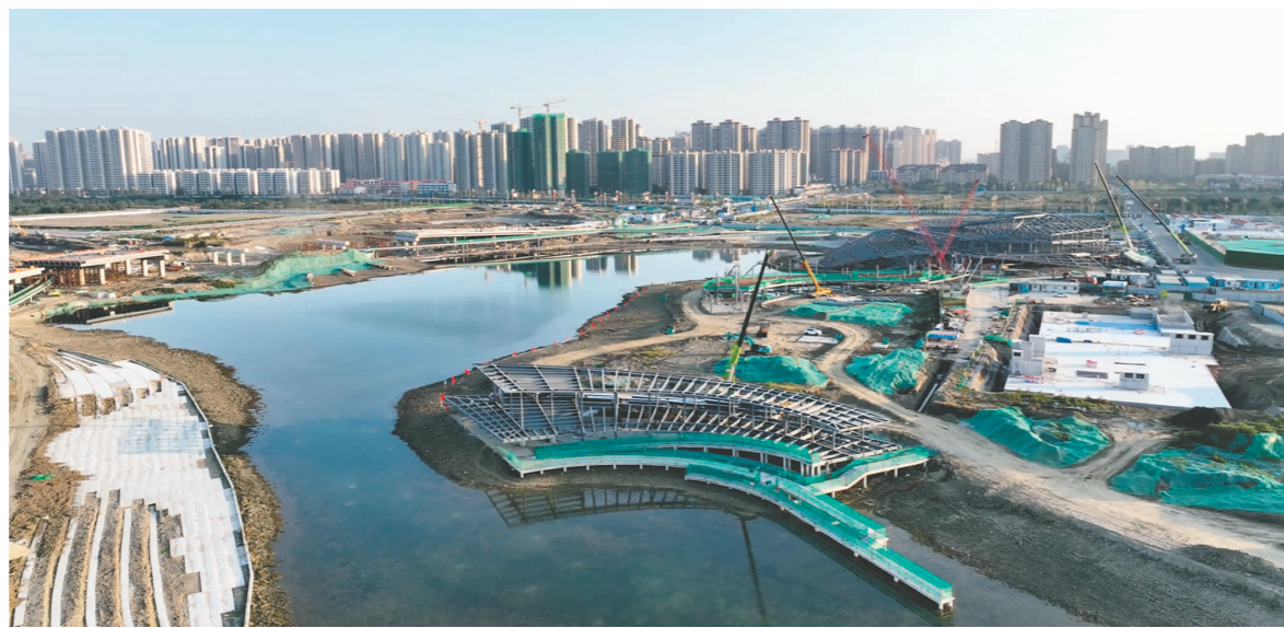
水晶画舫建设现场。
