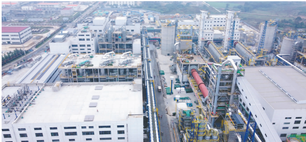
项目建设现场。
