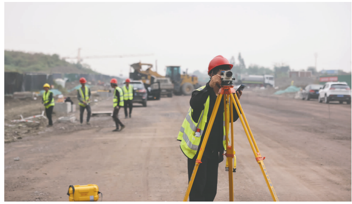
项目建设现场,施工工人正在测距。
