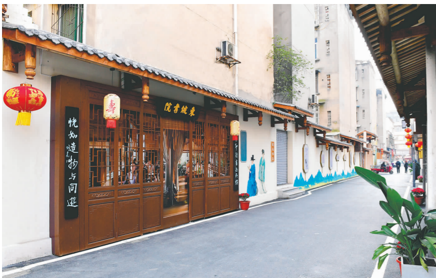
老城更新改造后的为民巷。我市不断提升老旧街区服务功能,实现小微空间改造升级,提升城市品质,塑造人性化城市、人文化气息、人情味生活。
