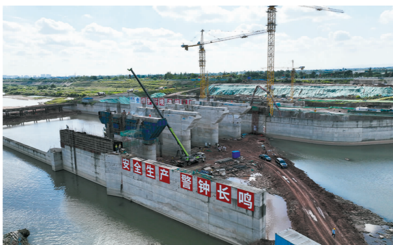
建设中的岷江彭山尖子山航电枢纽项目(局部)。
