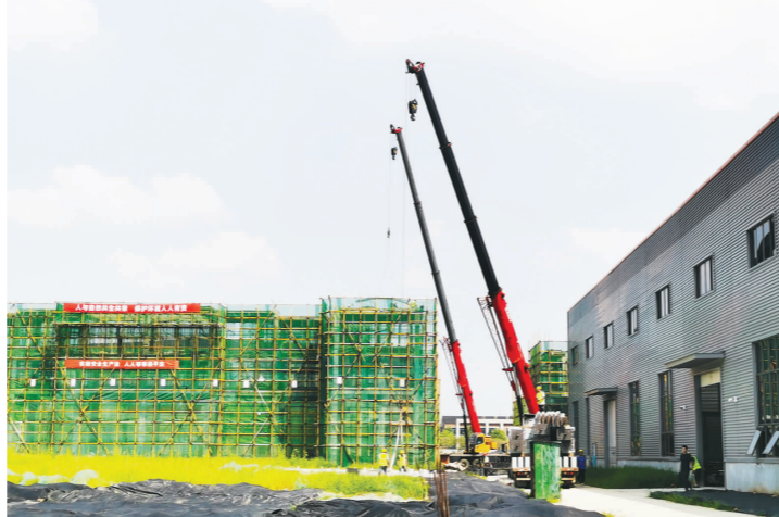
我市工业项目正在加紧建设。
