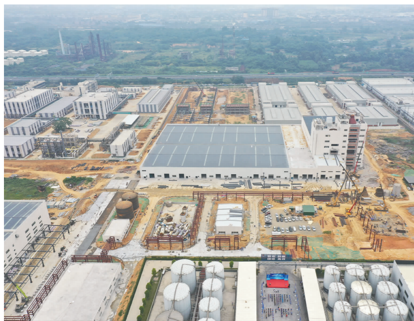
项目施工现场。
