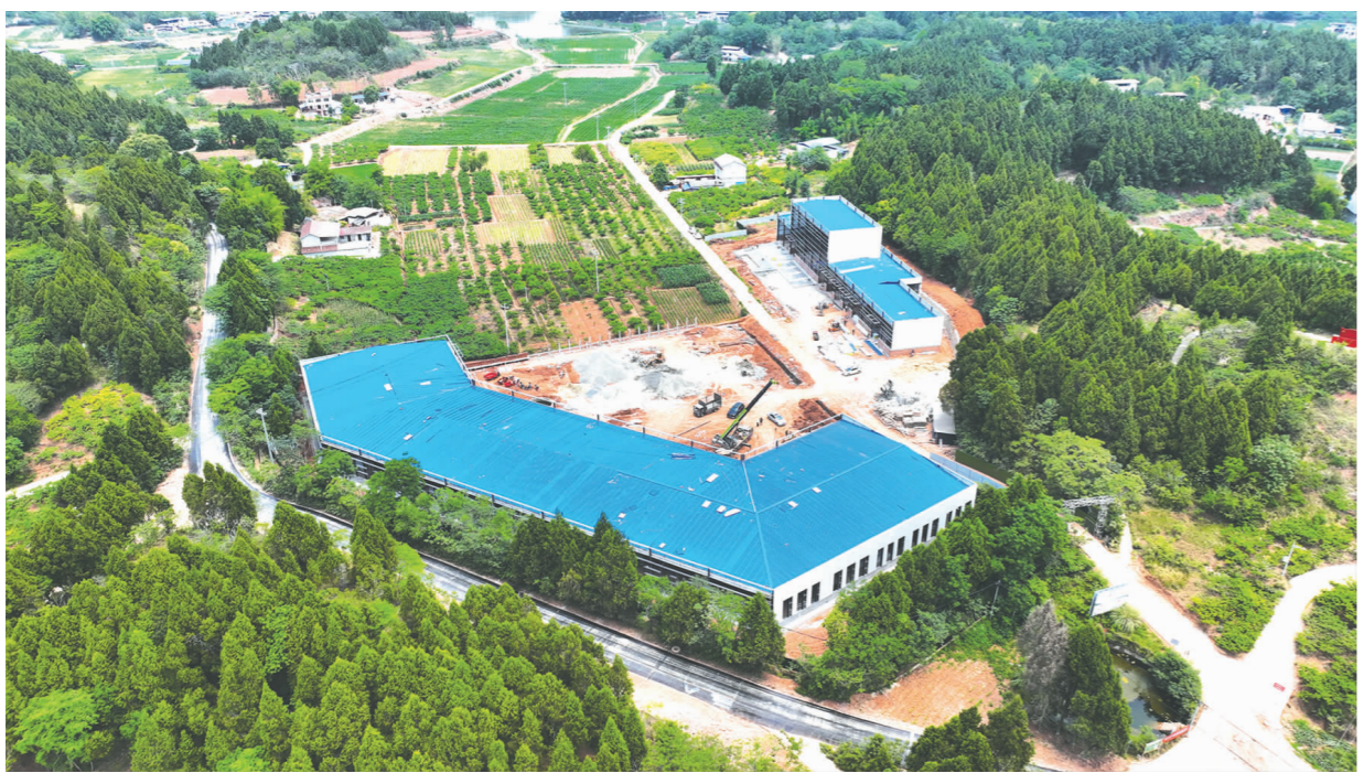
眉山天府新区正着力打造新时代更高水平“天府粮仓”。
