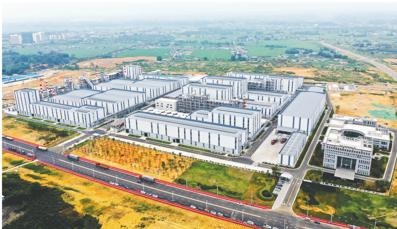
天华时代电池级氢氧化锂项目。眉山日报全媒体首席记者 李幸 摄
