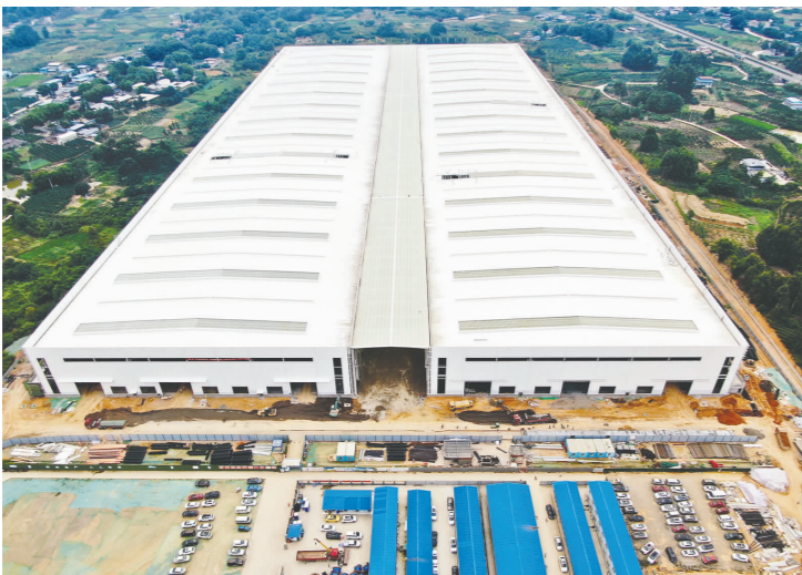
四川交投钢构制造产业基地项目。眉山日报全媒体记者 雷同 摄
