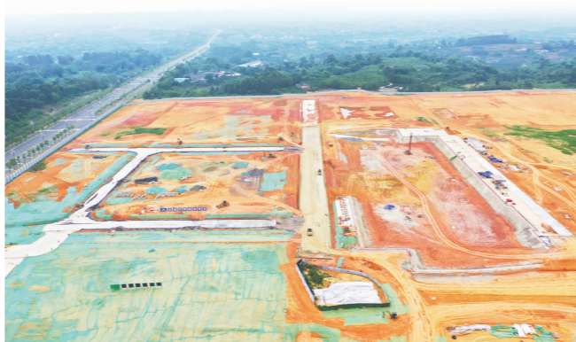
川大眉山校区正在进行土石方工程施工。 眉山日报全媒体首席记者 李幸 摄
