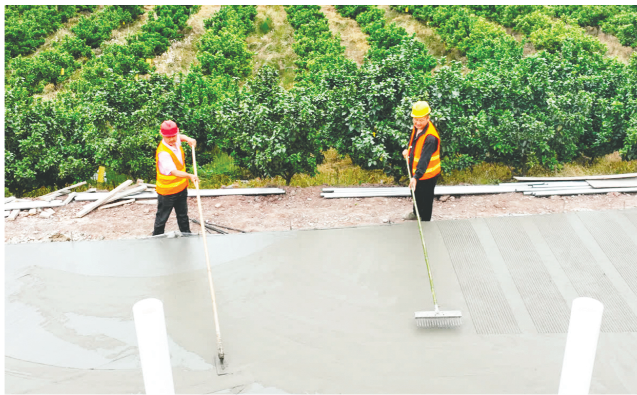
以工代赈项目建设现场。
