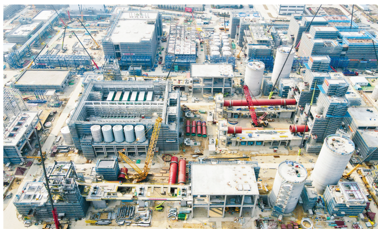
雅保眉山项目建设现场。
