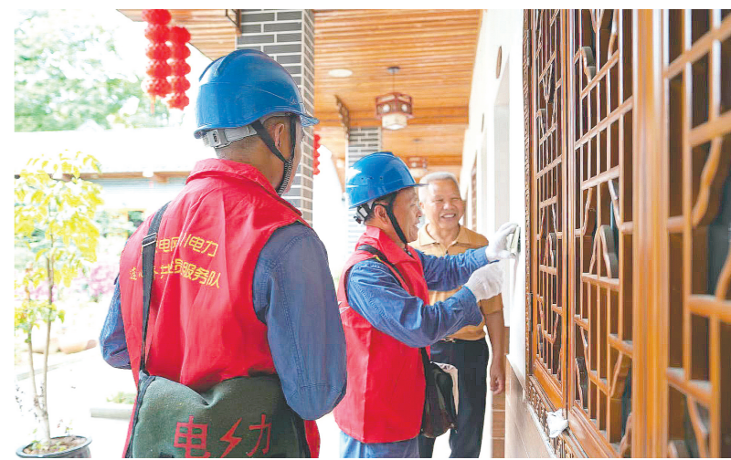
电力工人维修农家乐路灯开关。
