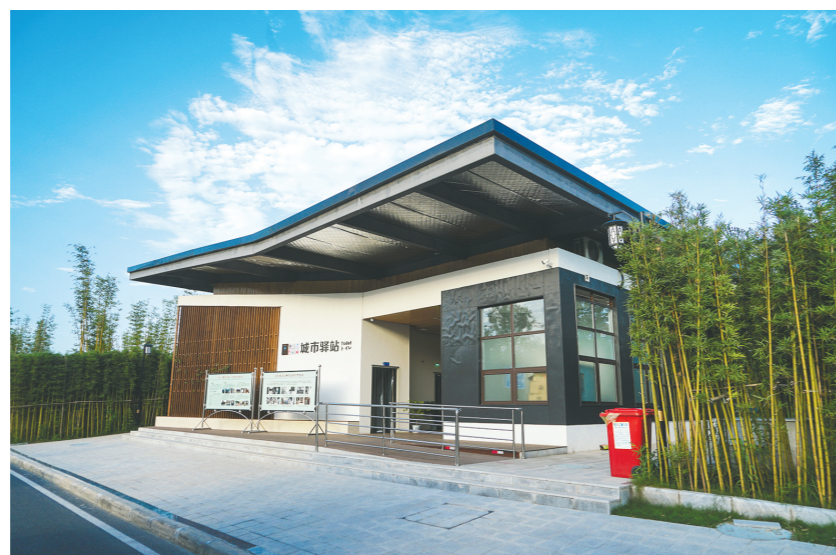
东坡区1号城市驿站旅游厕所。
