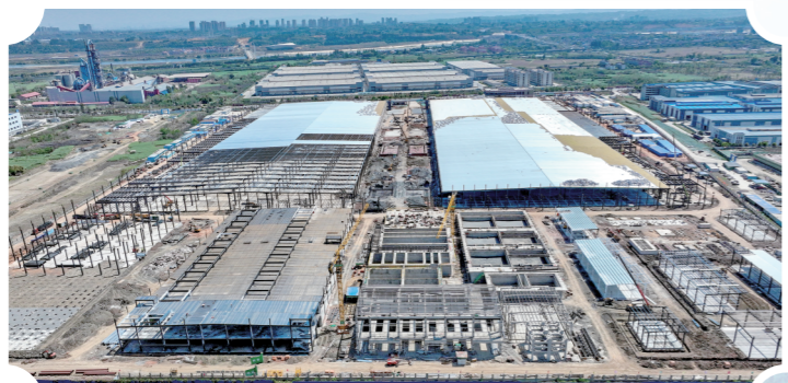
朝天。通威32GW太阳能电池项目(一期)施工现场一派热火朝天。
