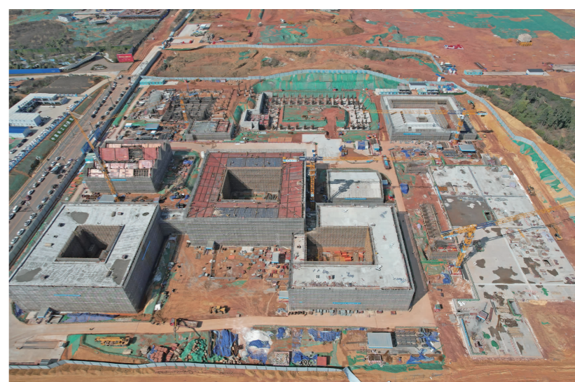
清华附中眉山天府学校(筹)建设现场。
