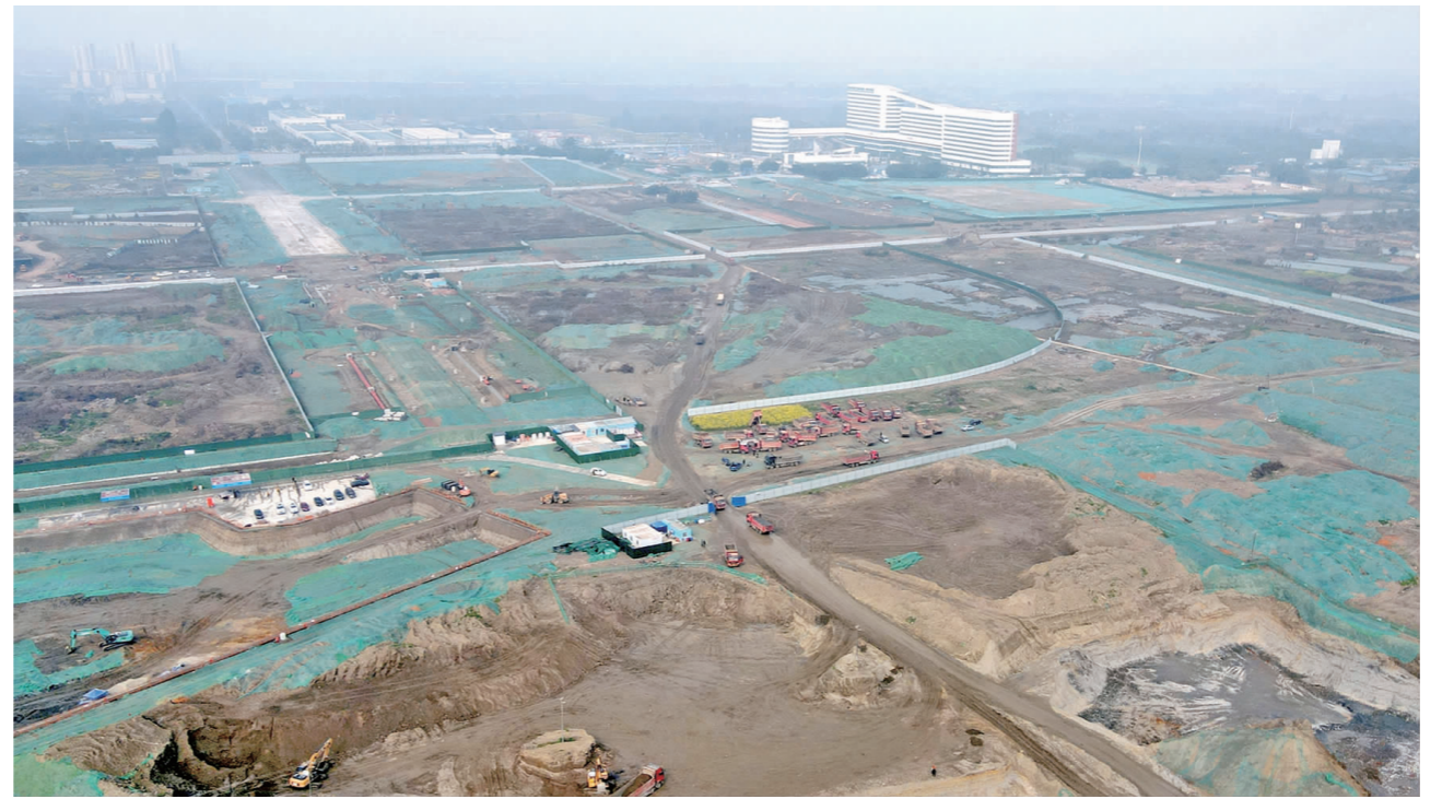
航拍眉山城市新中心太和公园施工现场。
