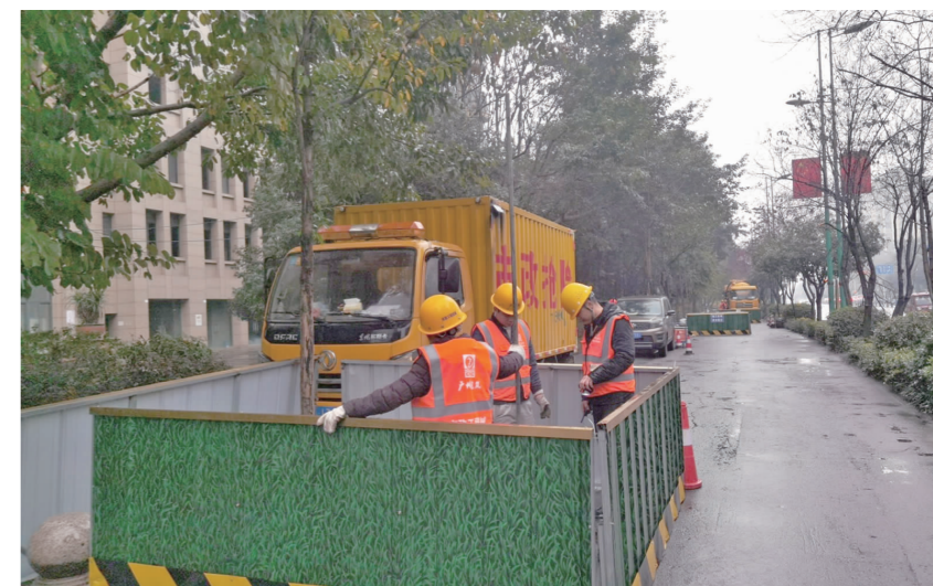
施工人员正在进行现场作业。
