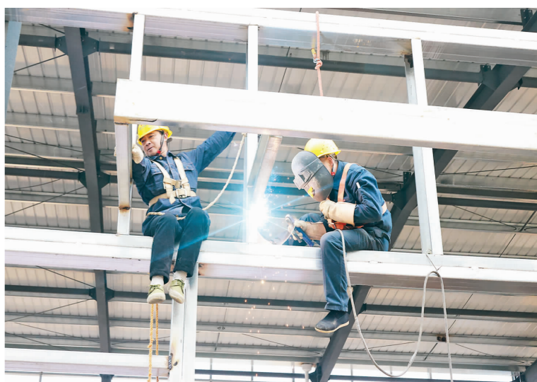
工人正在施工。
