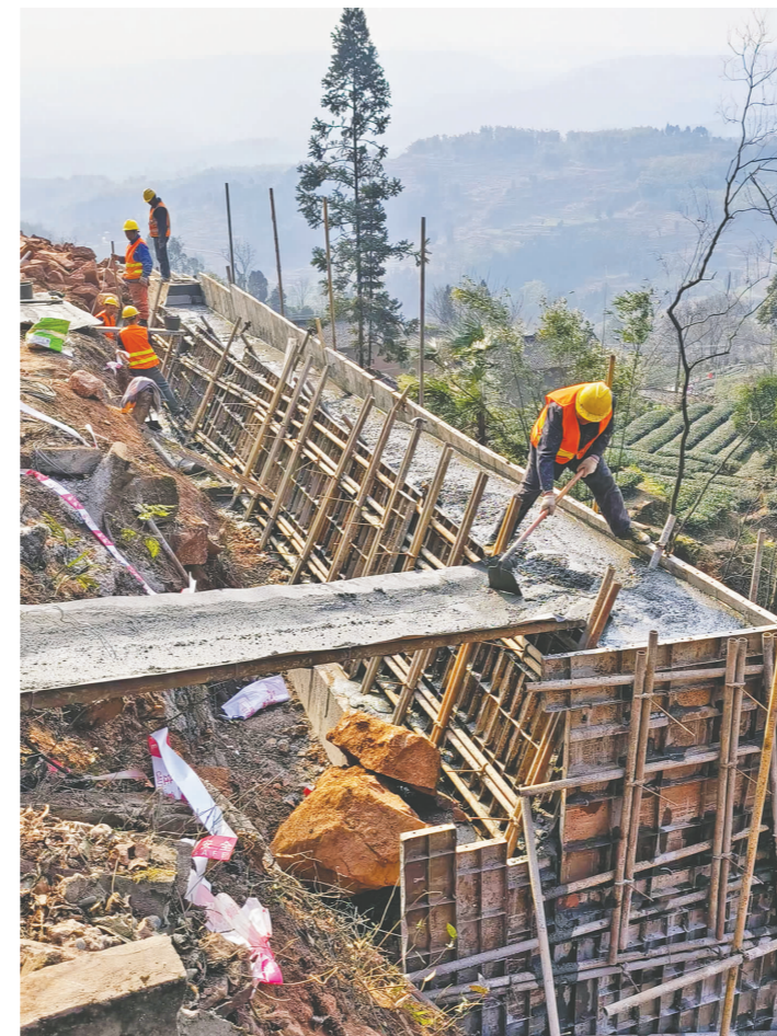
长秋山旅游公路顺龙至老峨山段项目工人正在进行挡墙施工。
