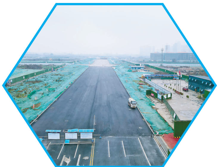
眉山城市新中心项目建设现场。
