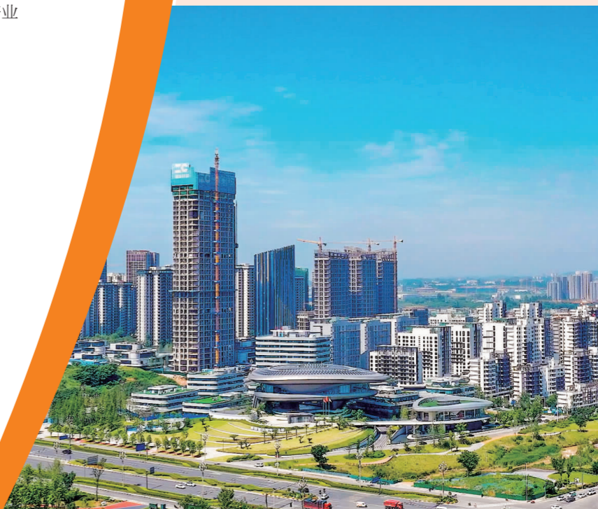
眉山天府新区数字化转型促进中心建设项目。
