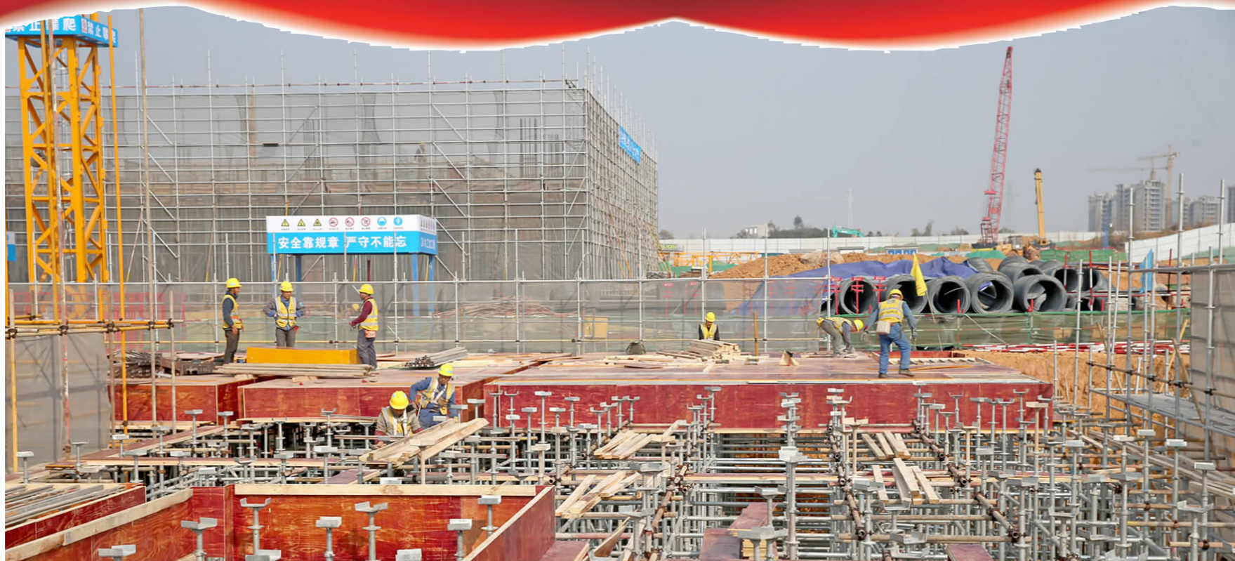
眉山天府学校（清华附中）项目正在建设中。
