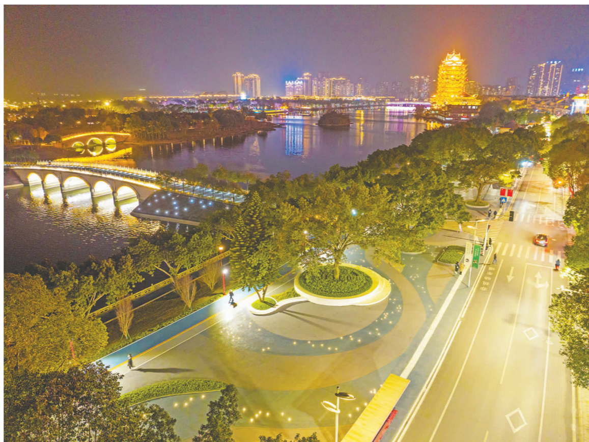
改造后的东坡步道。
