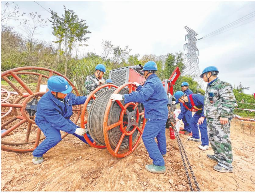
2022年11月30日,杉杉220千伏输电线路施工现场。
