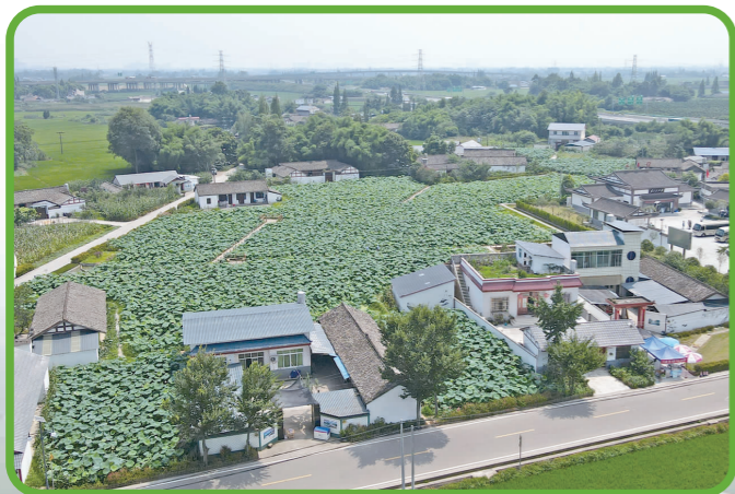
永丰村污水处理。
