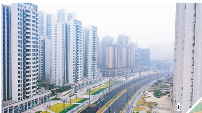
①焕然一新的花海大道。 ②光纤车间里,工人正抓紧生产。 ③彭山区精神卫生保健院项目正抓紧建设。
