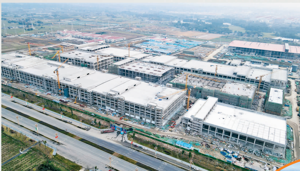
中创新航项目建设现场。
