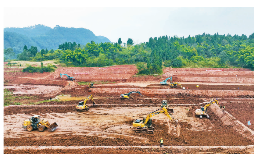
12月9日，在仁寿县曹家镇共城村高标准农田项目建设现场，10多台挖掘机、装载机正来回穿梭，抢抓晴好天气抢施工。2022年，仁寿县计划建设高标准农
