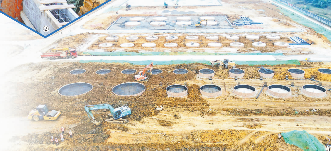
③四川天赐年产30万吨电解液项目建设现场。
