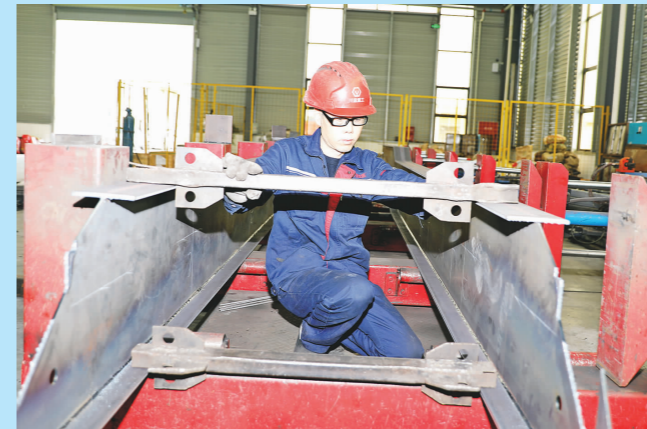
通过搭建横梁并进行焊接，2根粗重的大梁完成组对。
