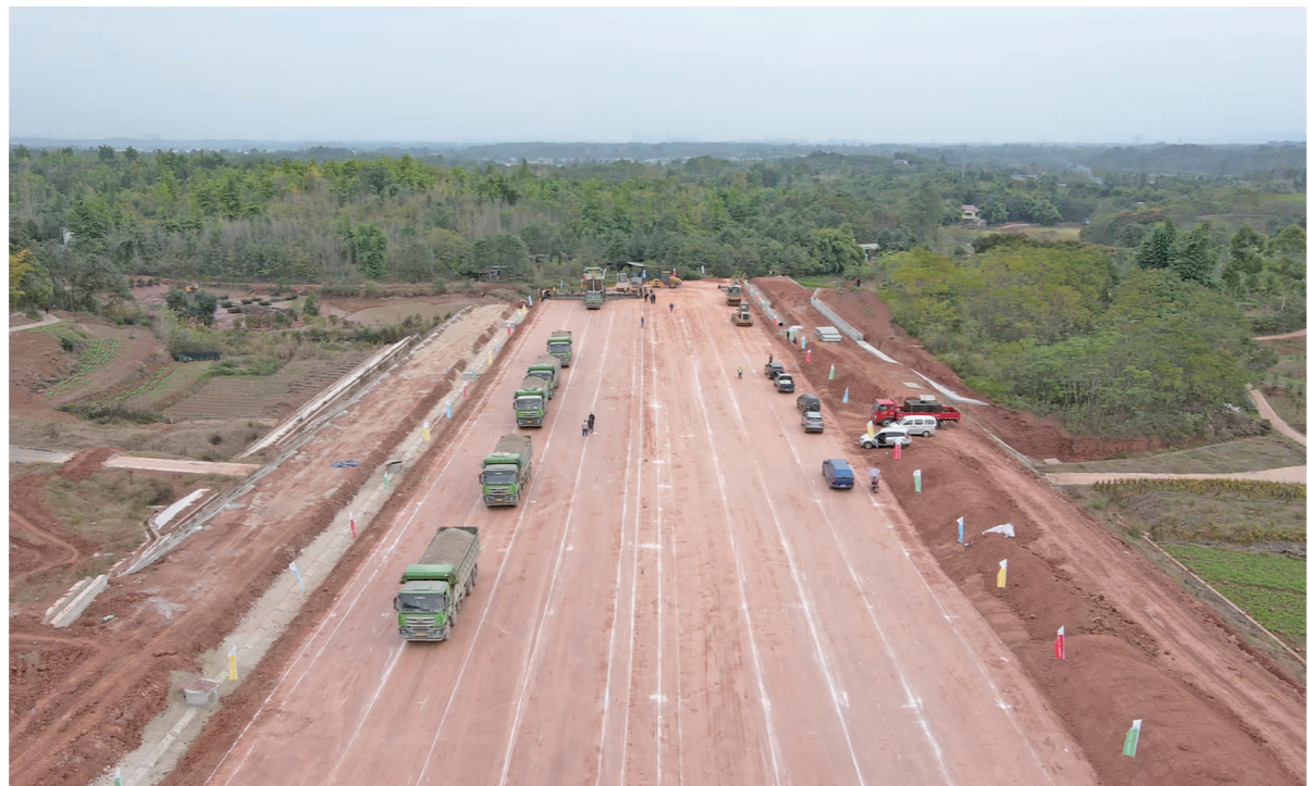
路面摊铺施工现场。
