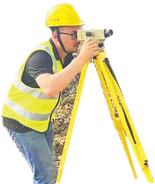
高标准农田建设现场,工人正在进行测量。
