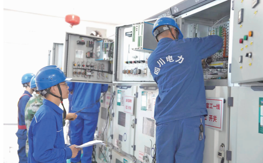
变电站综合自动化改造现场。
