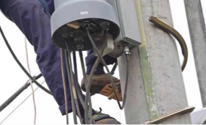
施工人员进行智能化柱上断路器。
