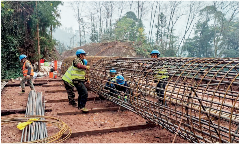
工人进行钢筋笼施工。
