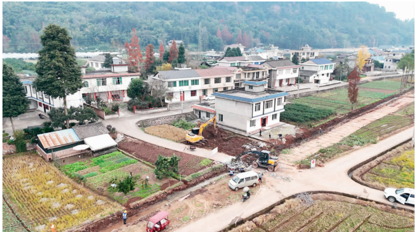
联丰村正在实施道路加宽作业。
