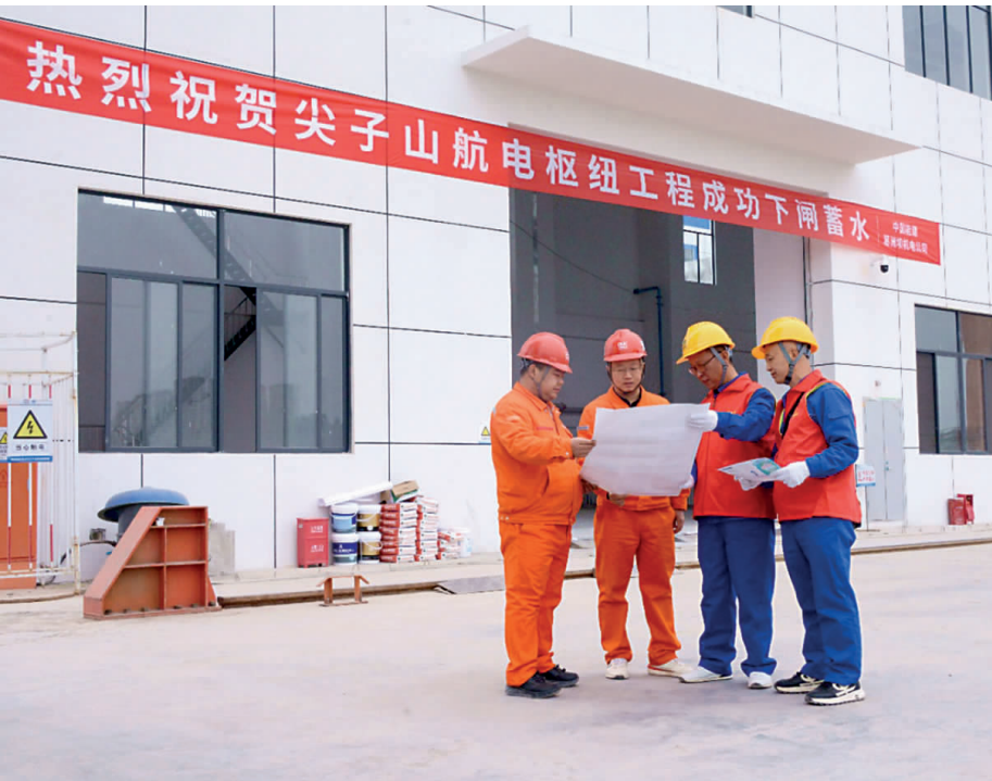
电力人员在航电工程现场宣讲安全用电知识。
