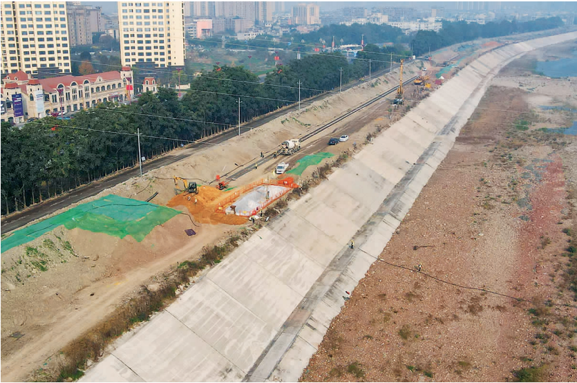
岷江彭山城区护岸和生态环境整治及滨江大道项目正在施工。
