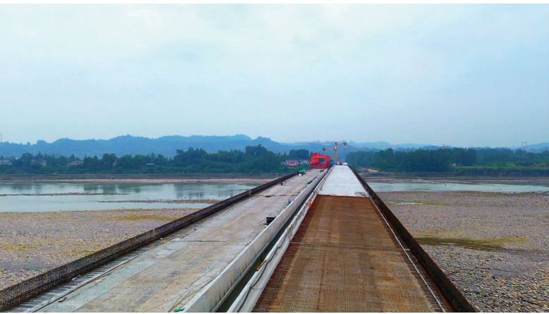
洪雅通用机场连接线项目桥面建设。帅玉洁 眉山融媒记者 李勇军 摄
