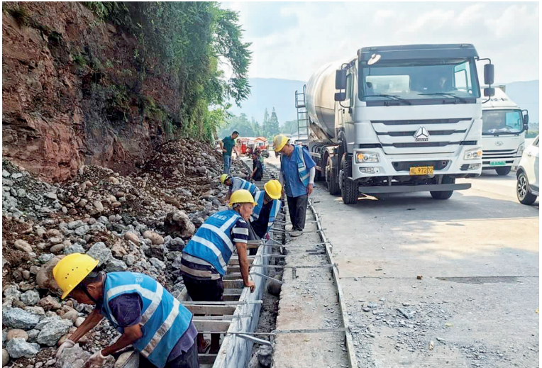
项目现场工人正在进行边沟作业。
