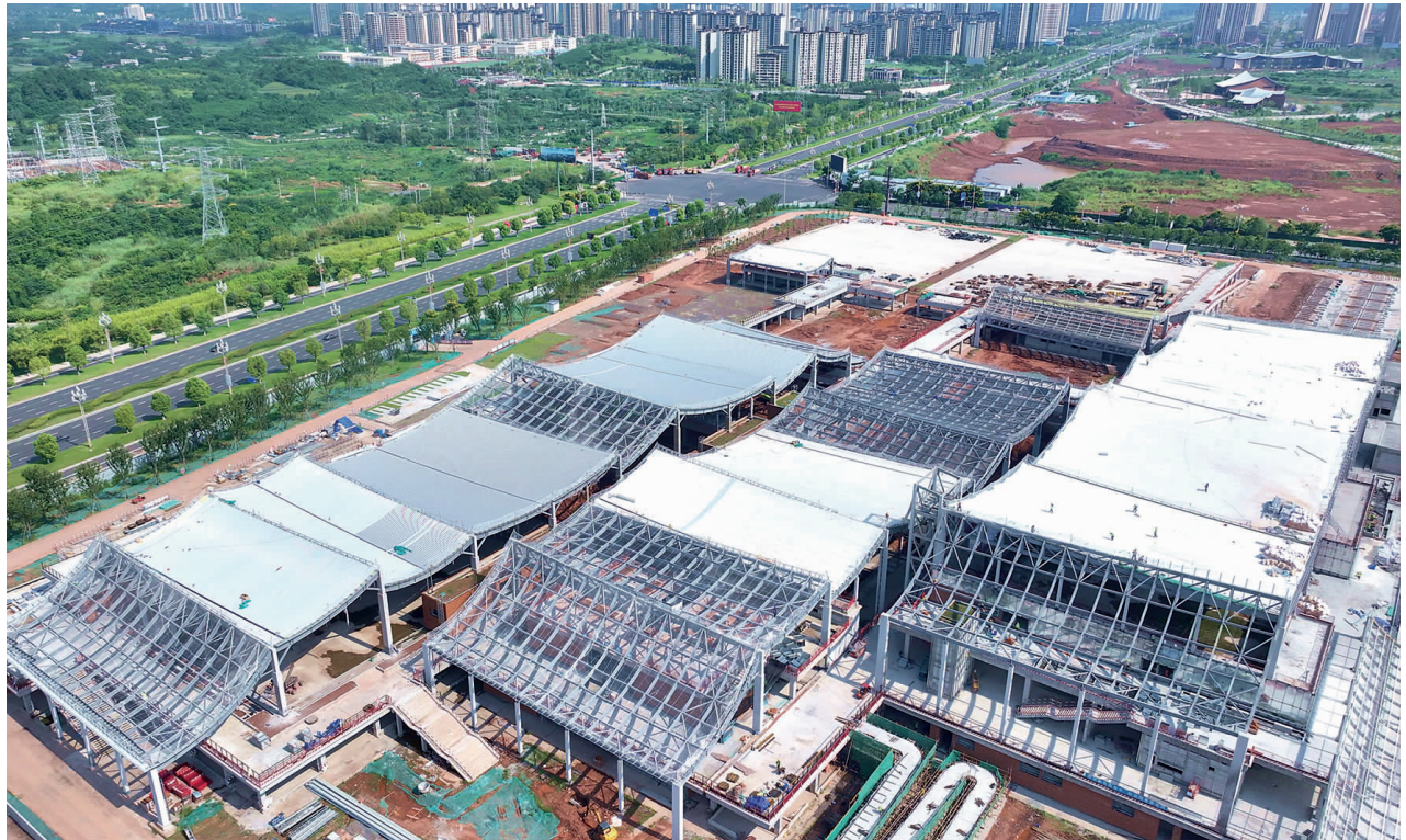
航拍仁寿县体育中心建设现场。
