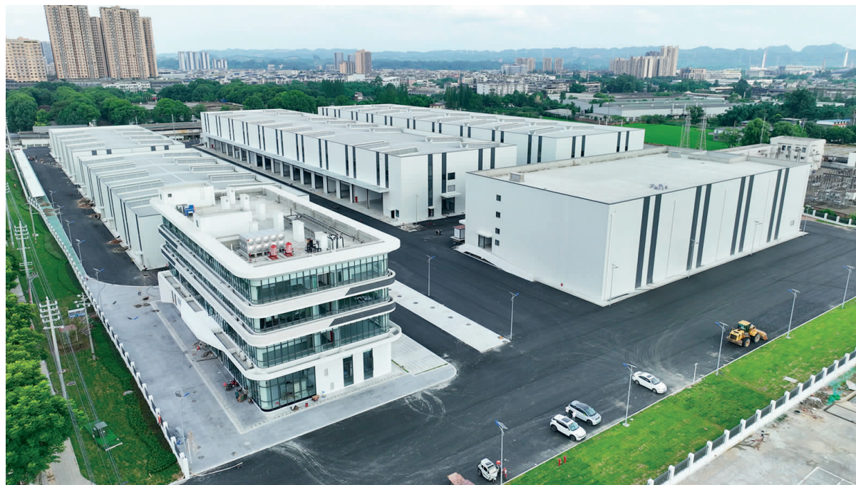
青神县综合物流园区项目一角。
