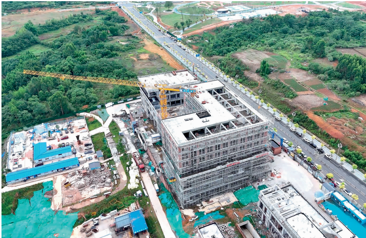
眉山天府新区第二人民医院项目建设现场。
