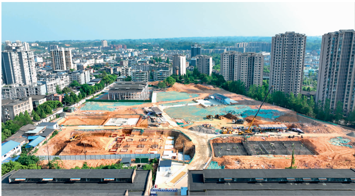
丹棱县九年一贯制学校项目建设现场。
