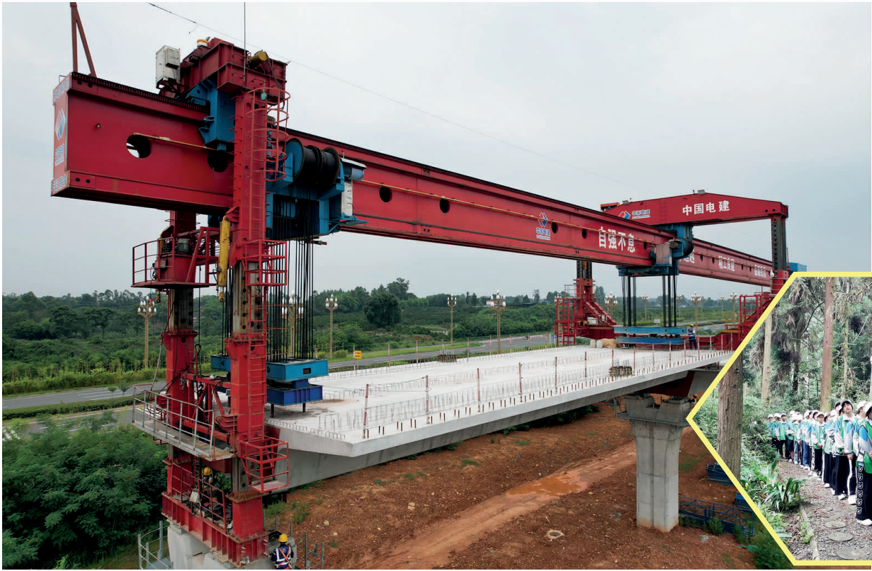
▲图为正在建设的市域(郊)铁路成眉S5线岷东新区段。 眉山融媒首席记者 李幸 摄
