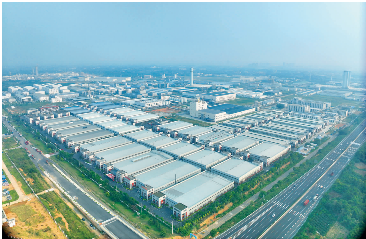
眉山高新技术产业园区。
