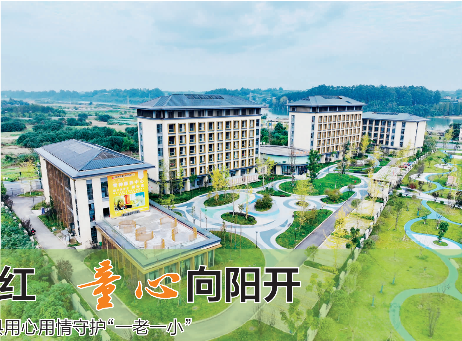
眉山市养老服务中心青神区域中心。
